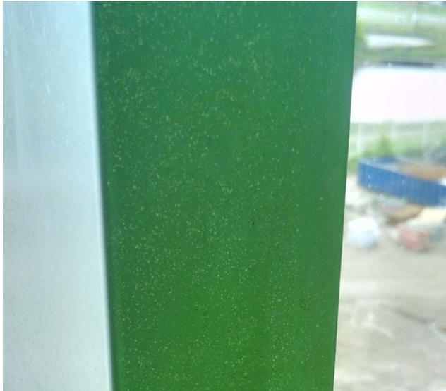
Groen profiel aangetast met witte spikkels van verfpistool.
